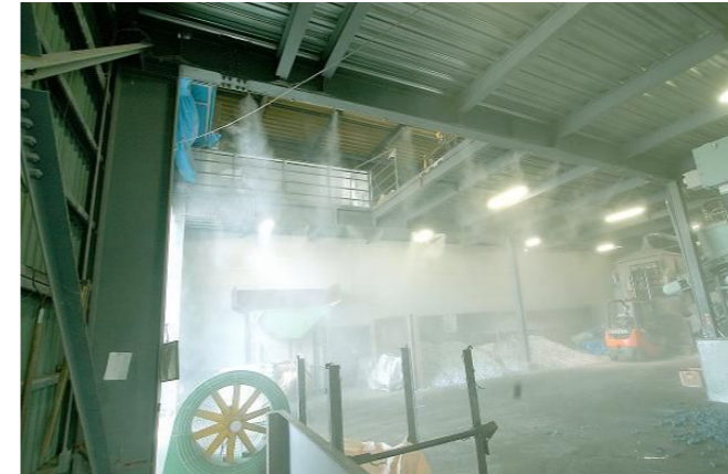
産廃処理工場内部
