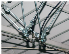
ステンレス管とナイロンパイプ接
